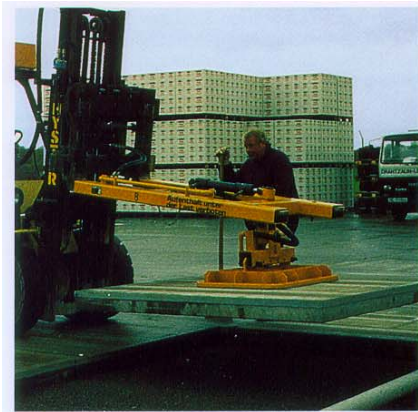
Verlegung mit geeignetem Verlegegerät
