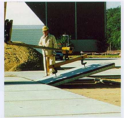
Verlegung mit geeigneter Traverse und Hubschlüssel
