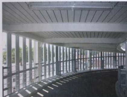
Bild 3. Spindelfahrbahn (Fotos: spannverbund)
