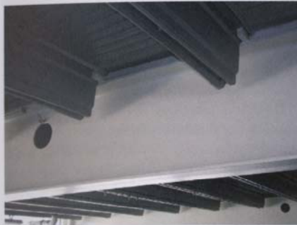
Bild 2. Ausführungsdetail Träger/Additivdecke
