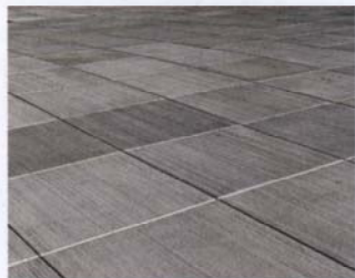
Bild 2. Die Fahrbahnplatten zeichnen sich neben der hohen Verschleißfestigkeit und Rutschhemmung auch durch eine gleichmäßige Optik aus
