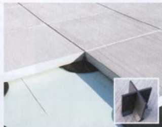
Bild 3. Durch höhenmäßig abgestufte Stelzlager wird ein gleichmäßiges Auflager auf der Dämmung sichergestellt; die besondere Form der Abstandhalter hält diese ortsfest an den Kreuzungspunkten (Bilder: BTE Stelcon)
