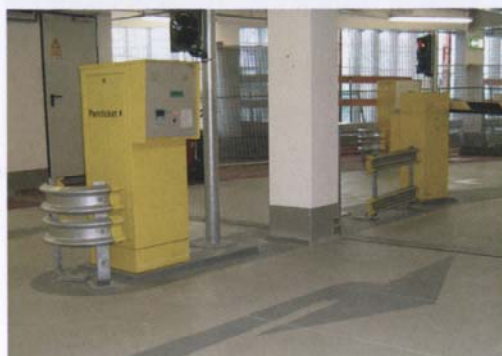
Bild 2. Anfahrtschutz an den Kartengebern und den Schrankenanlagen (Fotos: Atlantex Schutzsysteme)
