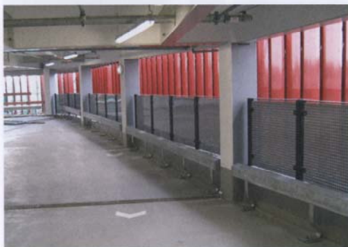
Bild 1. Hauptparkhaus P33 am Frankfurter Flughafen: Anprallschutz zwischen den Stahlbetonstützen
