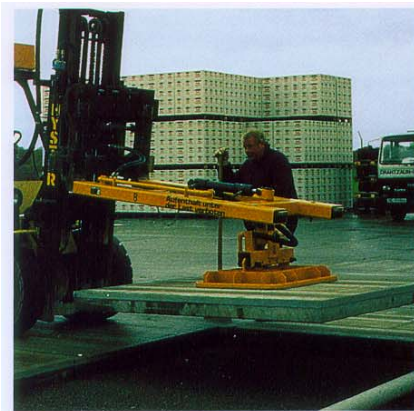
Verlegung mit geeignetem Verlegegerät
