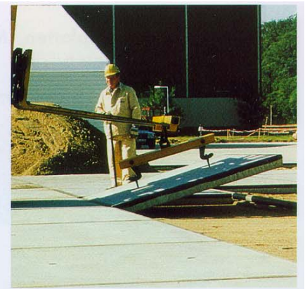
Verlegung mit geeigneter Traverse und Hubschlüssel
