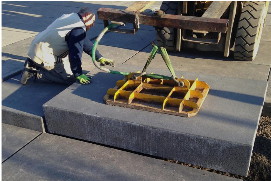
Bild 5: Verlegung mit Vakuumhebergerät
