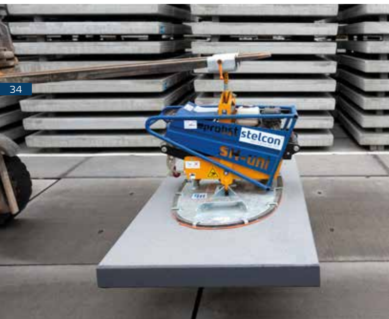
Mit Kran oder Hubstapler nie mehr als 3 Platten gleichzeitig heben!
