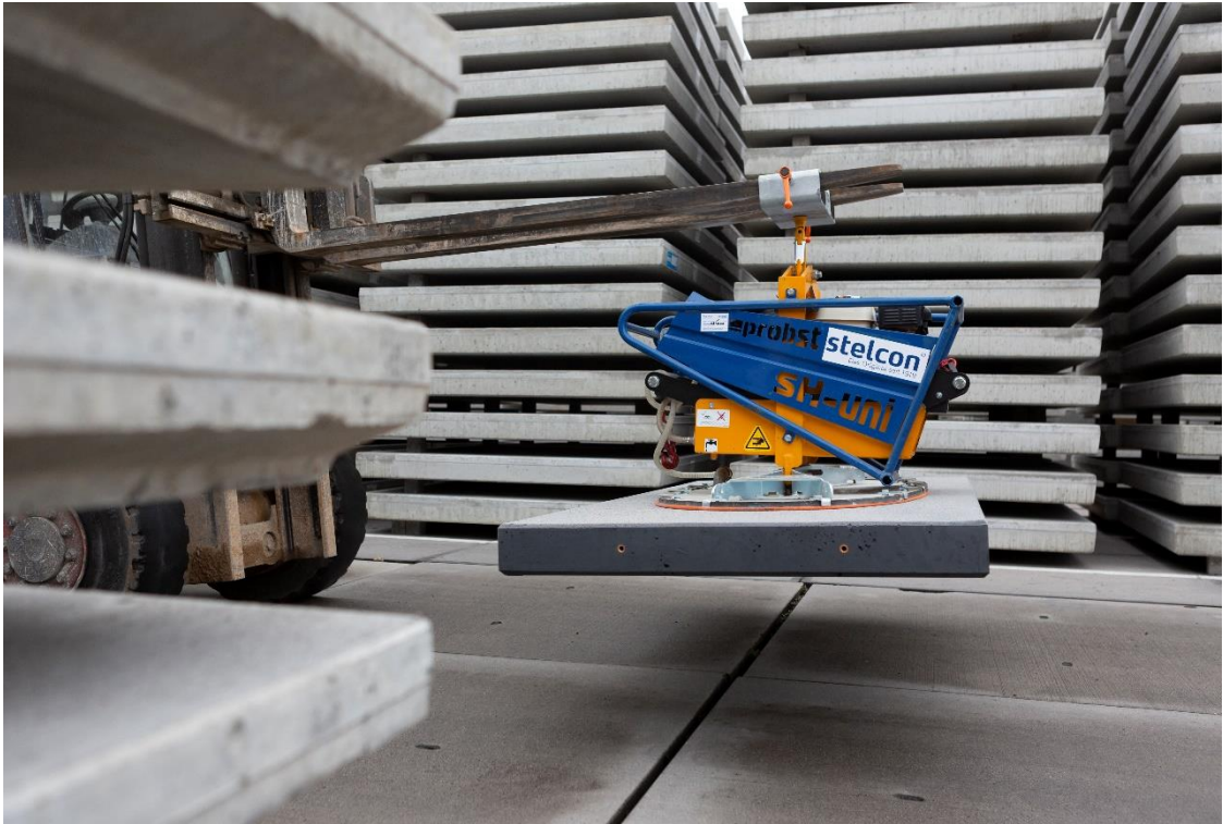
Bild 3: Verlegung mit Vakuumhebergerät
